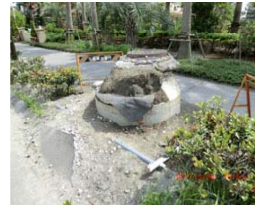
液状化の状況. 千葉県浦安市
